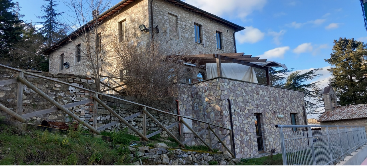
FOTO 5 : PROSPETTO SUD EST
