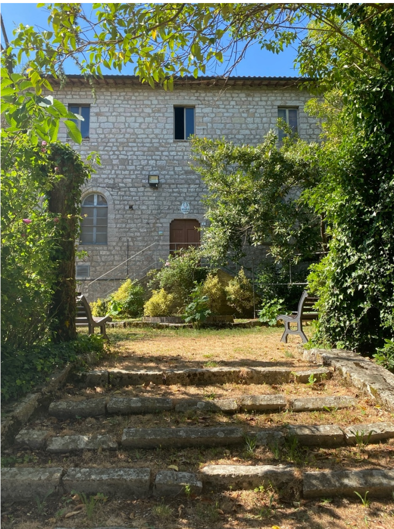
FOTO 2 : PROSPETTO NORD – PARTICOLARE
