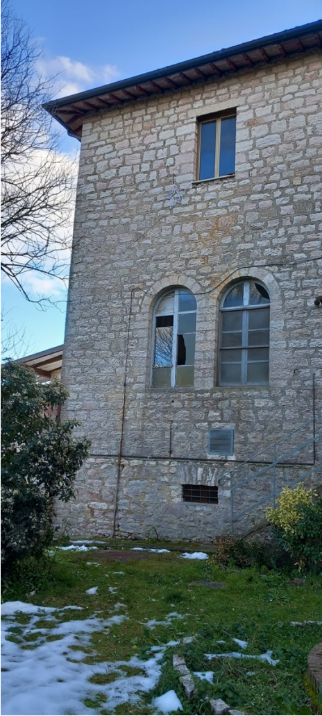
FOTO 3 : PROSPETTO NORD – PARTICOLARE
